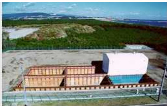
定置開始前 (トレンチ外観及び雨水浸入防止用テント)
