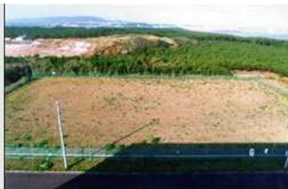
埋設終了 (保全段階)
