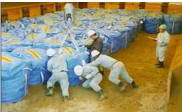
廃棄物定置作業
