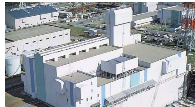
高レベル放射性廃棄物貯蔵管理センター外観
