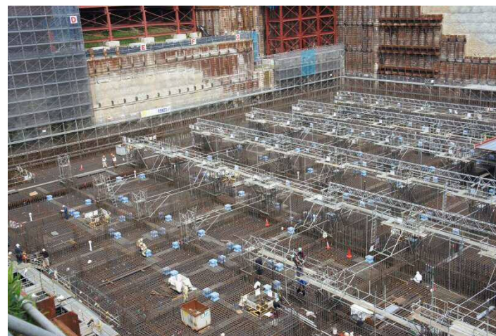
MOX燃料工場 建設工事現場風景
