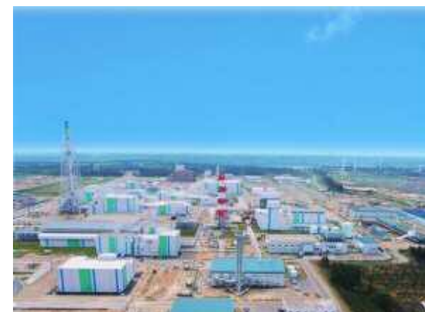
再処理工場の外観
