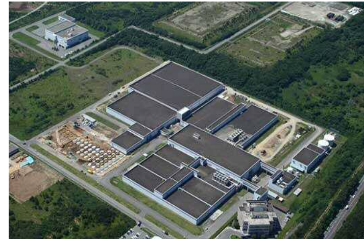
ウラン濃縮工場外観
