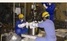
設備機器の点検及び更新
